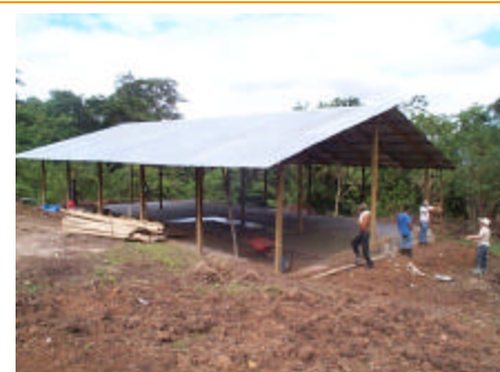
Construcción empacadora de gengibre
