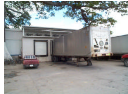
Muelle de carga para vegetales orientales
