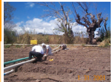
Instalación sistema de riego por goteo.
