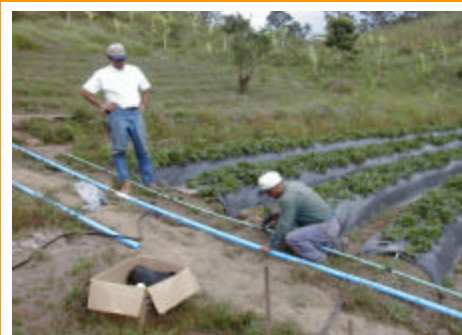
El CDA ha instalado 80 sistemas de riego de 0.7 has. que aparte de contribuir a mejores productividades y expansión en siembras, también ha mejorado el uso del agua, reduciendo el consumo total, reduciendo la erosión, y permitiendo una fertilización más precisa.
