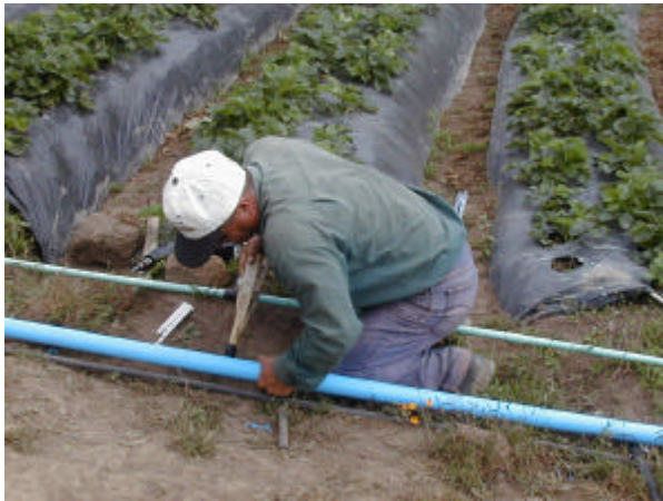
Instalación de sistemas demostrativos de riego por goteo
