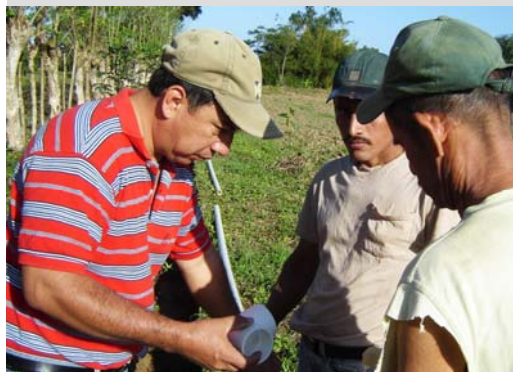
Instalación de sistema de riego por goteo en finca de beneficiario de USAID – RED. Bajo Aguán, Yoro
