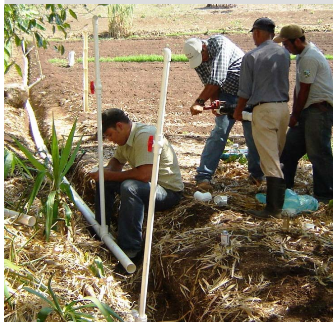
Instalación de sistema de riego por goteo, Intibucá
