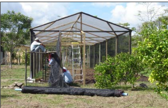
Construcción de Invernaderos de bajo costo en Finca Modelo
