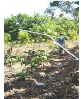
Instalación de sistema de riego por goteo
