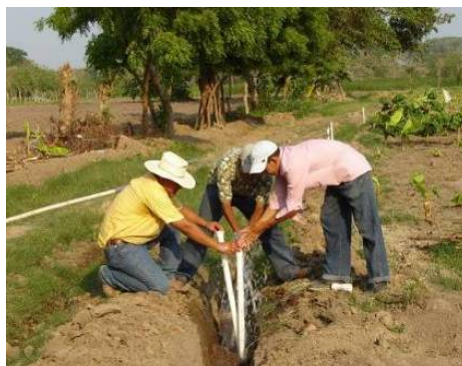
Estudiantes trabajan en la instalación de un sistema de riego
