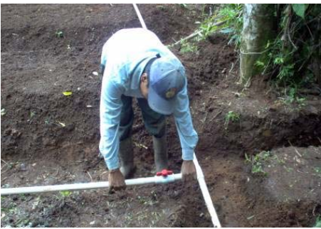
Instalación de un sistema de riego por goteo
