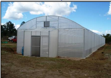
Infraestructura de un invernadero.
