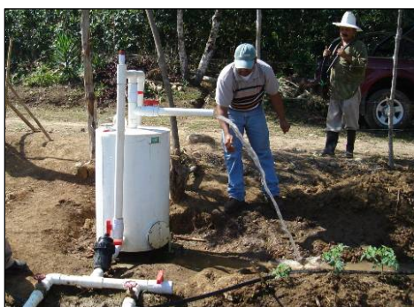
Construcción e instalación de filtro
