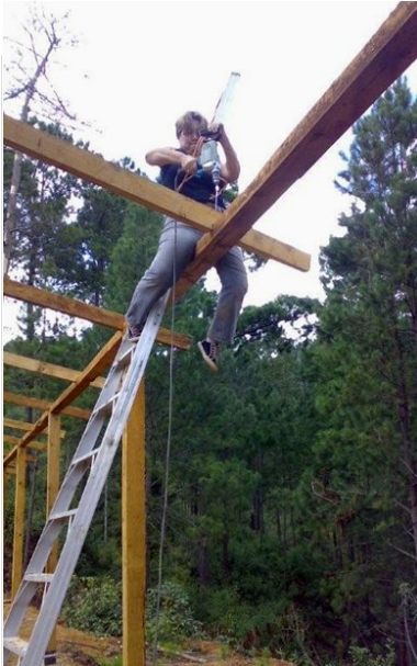
Fotografías: Fintrac Inc. Carmen Vásquez construyendo un invernadero en su finca.
