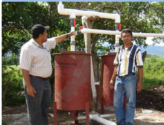
Instalación de sistema de riego, Comayagua
