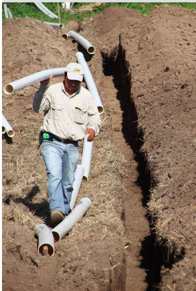
Instalación Sistema de Riego- Olanchito
