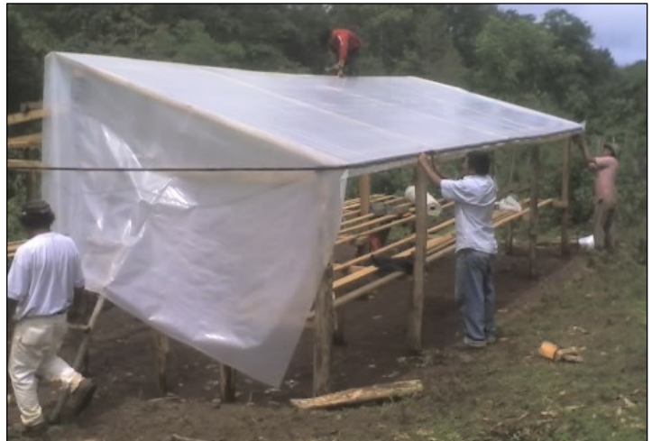
Construcción de invernadero para grupo en Marcala, La Paz
