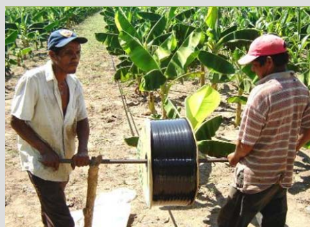
Instalación de Sistema de Riego - Olanchito
