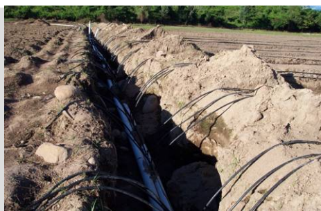
Instalación de Sistemas de Riego
